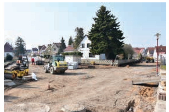
Die Absperrbake in der Sebastian-Bach-Straße weist auf die aktuell begonnene Baustelle hin (Foto ganz oben).
