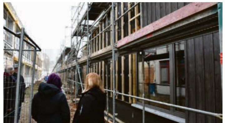
Ein Teil der neuen Kita erhielt schon seine zukünftige neue Außenfassade in moderner Holzoptik. Gegenüber steht der Zweigeschossler, der derzeit noch genutzt wird.
