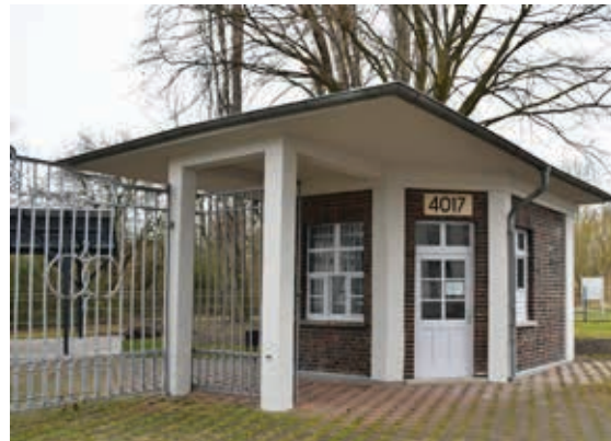
Außenansicht vom Torhaus 8 nach den Außenarbeiten am Gebäude, von denen wir in der ersten Amtsblatt-Ausgabe des neuen Jahres berichteten.
