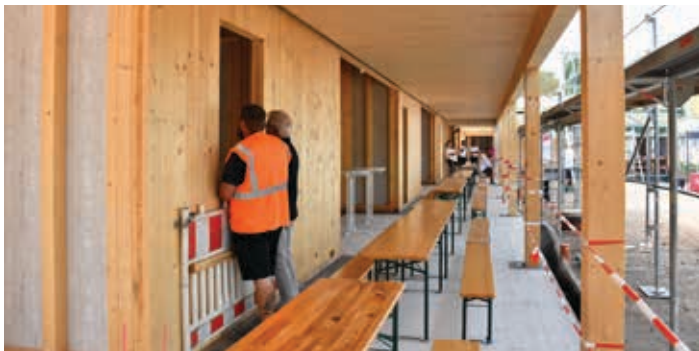
Beim Richtfest gab es natürlich auch die Möglichkeit, den Rohbau in Augenschein zu nehmen.
