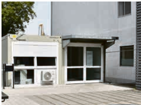
Der Haupteingang der KMG Klinik befindet sich momentan aufgrund der Bauarbeiten an der Rückfront des Gebäudes.
