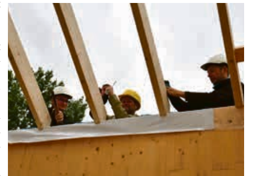
Auch Mitarbeiter der Uwe Quenzel Zimmerei und Tischlerei Leubingen sind auf der Baustelle am Wirken.
