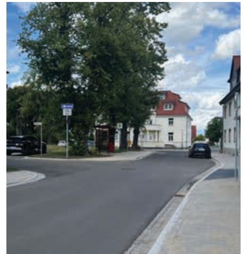
Blick auf den fertiggestellten Hegelplatz aus Richtung Mozartstraße samt barrierefreier Bushaltestelle
