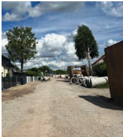
Blick aus Richard-Wagner-Straße Richtung Ortsumfahrung Sömmerda
