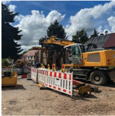
Derzeitige Kanalarbeiten durch die Firma Feickert GmbH
